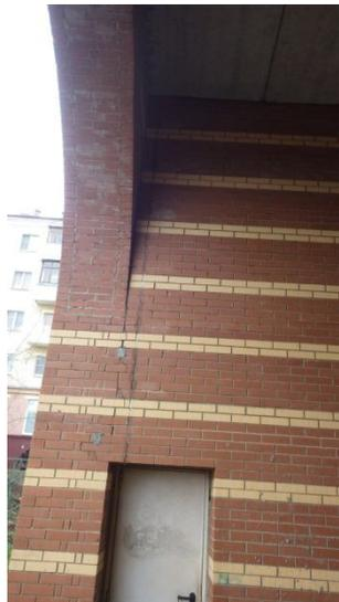
Трещина в осях 25-26/Ж (ближе к оси 26)
