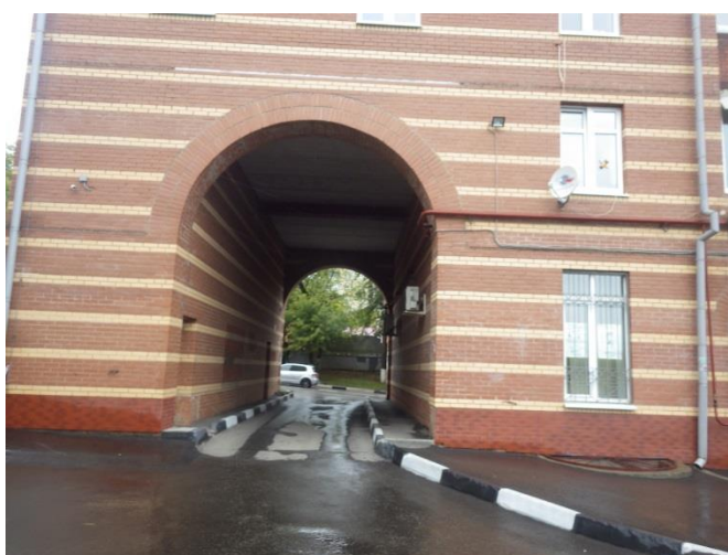
Фото 7-8. Арка в осях 25-26/А-И
