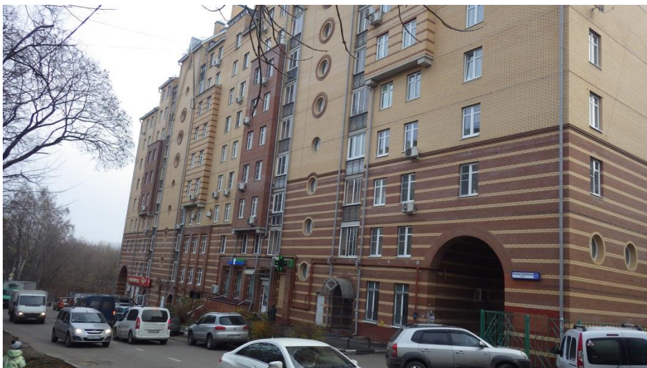
Фото 1. Фасад в осях 1-26/А
